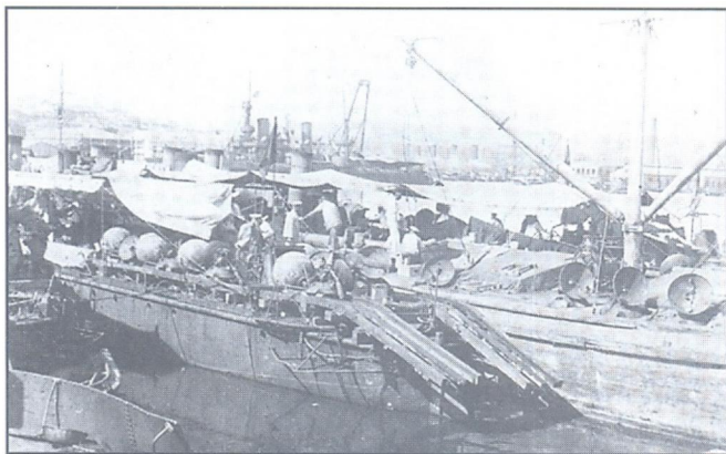
В кормовой части миноносца «Решительный» оборудованы «салазки» для постановки мин заграждения
