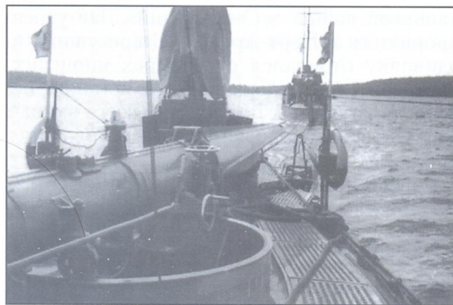
Вид на 380-мм торпедный аппарат миноносца
